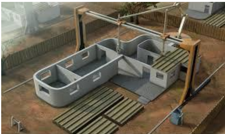
Рисунок 1 -3D-печать дома: процесс создания стен
