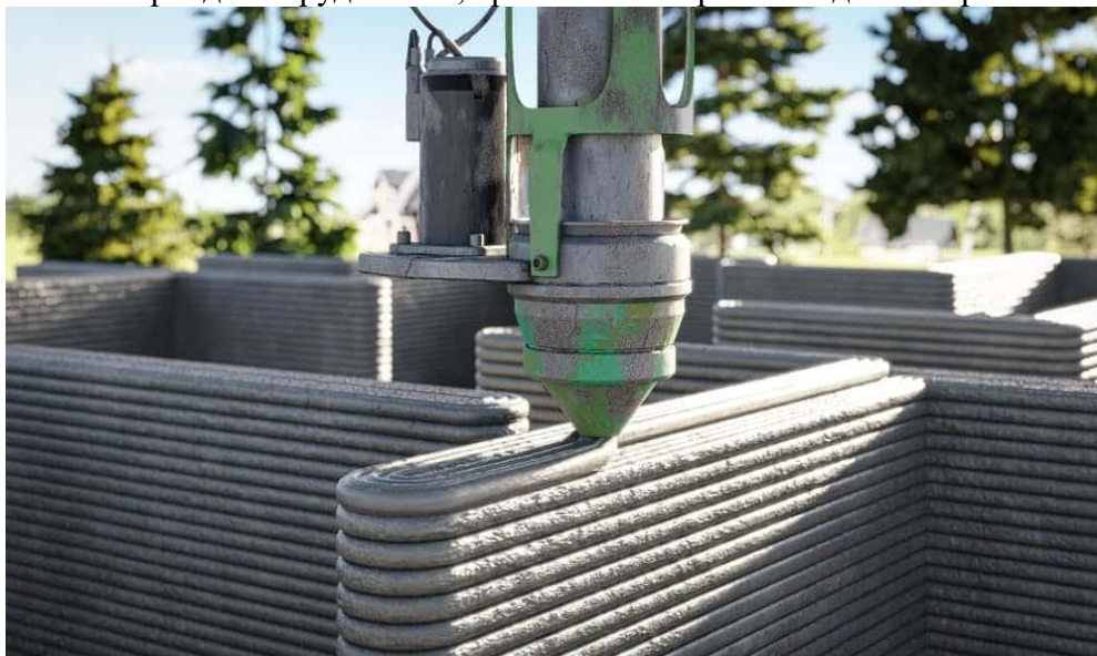
Рисунок 1 -3D-печать дома: процесс создания стен
